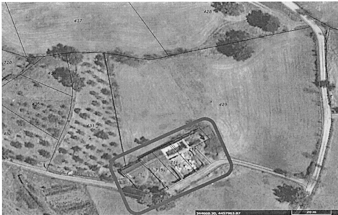
Fig. 2: Ortofoto de la parcela 1 donde se encuentran ubicadas las instalaciones. Fuente: En ella se muestra la delimitación de las parcelas (a) y la delimitación de los elementos construidos según el catastro digital.
