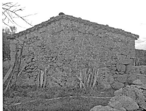
Fachada lateral oeste Pajar 1.
