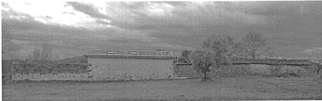
Fachada norte de los cuatro pajares.
