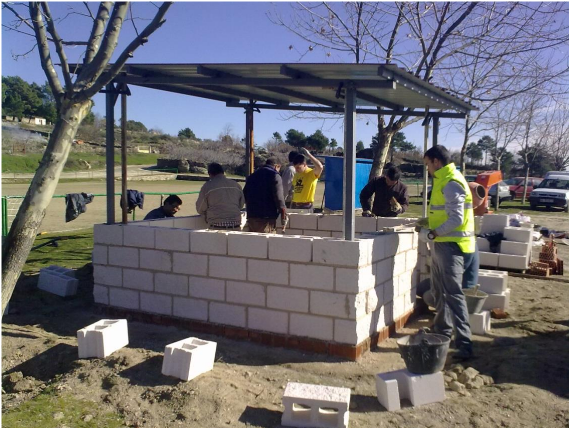
Construcción del nuevo kiosco-bar en Majaqueruela año 2011
