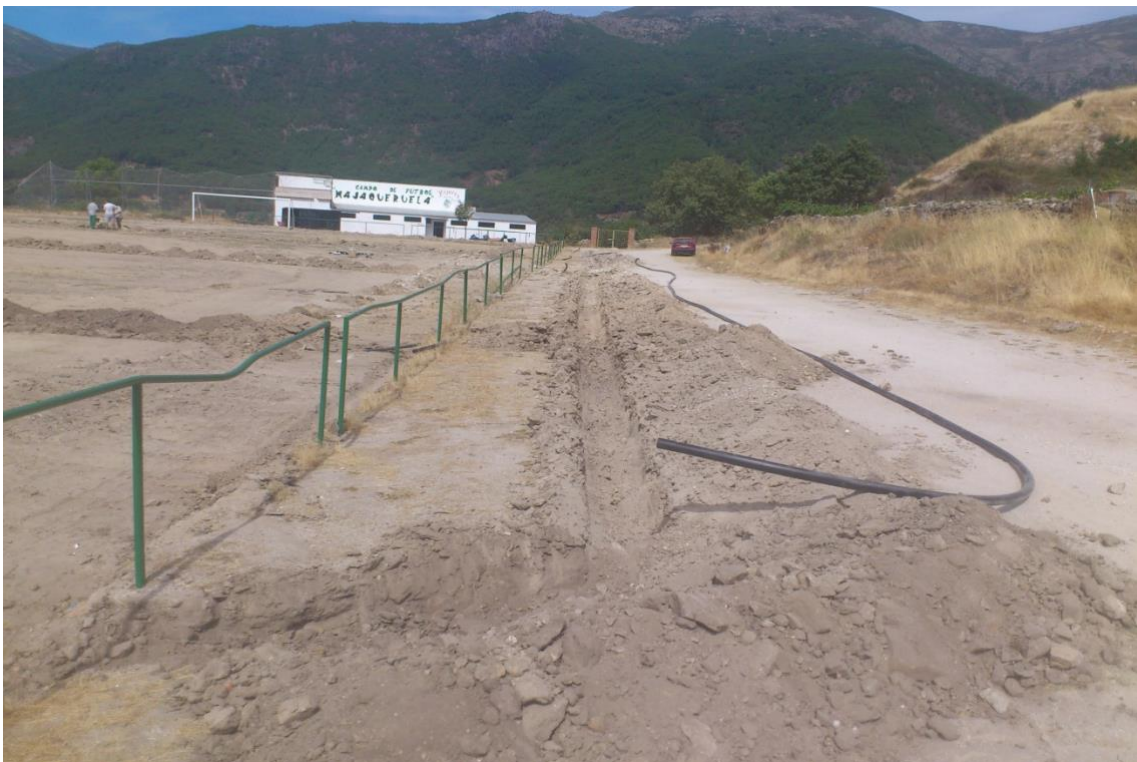
Obras de colocación del riego para el césped en Majaqueruela, año 2012
